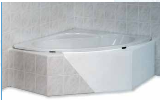
Eckwannenträger kurz vor Abschluß der Verfliesung
